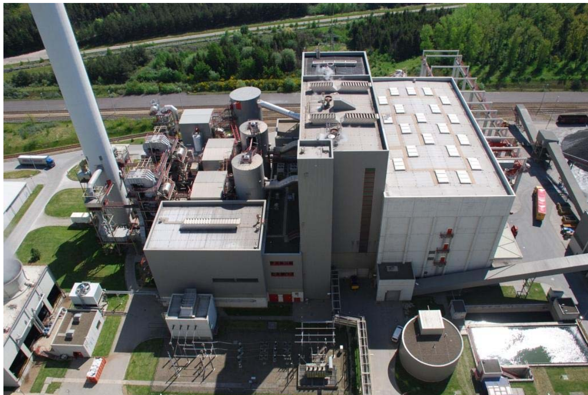
Bild 11: Thermische Restabfallvorbehandlungsanlage „TRV Buschhaus“
