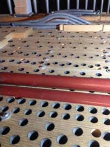
Im leeren Gehäuse der Orgel konnten die Tonventile der Windladen auf ihre Funktion überprüft werden.
