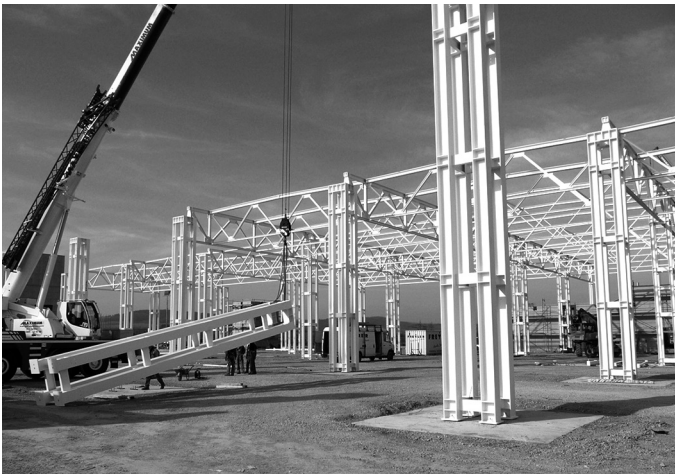
Bild 5. Stahlhalle mit eingespannten Stahlstützen (aufgelöste Rahmenstütze)
