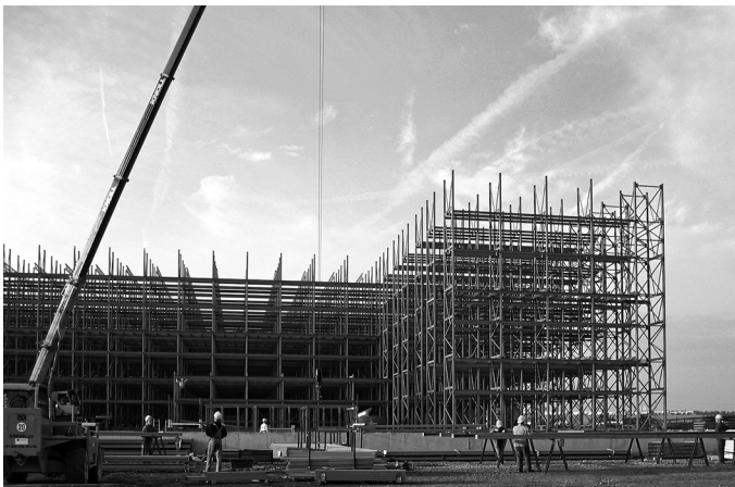
Bild 8. Hochregallager im Bau
