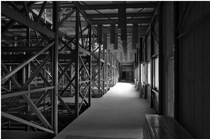
Bild 7. Hochregallager mit Aussteifungsturm und Kommissionierebenen
