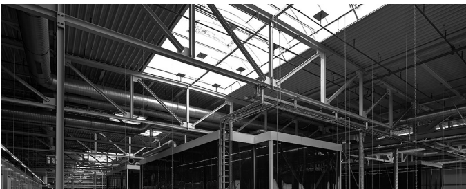
Bild 6. Fachwerkbindern mit Diagonalen aus I-Profilen
