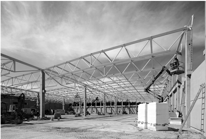
Bild 4. Halle mit Stahl-Fachwerkbindern auf Stahlbetonstützen
