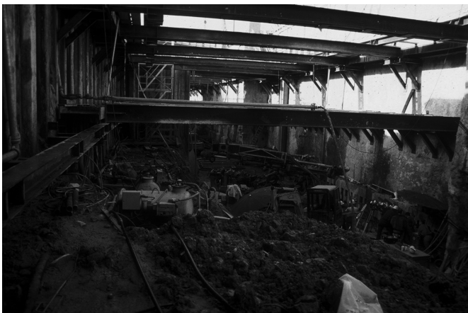
Abb. 1.1 Ausgesteifte Baugrube.
