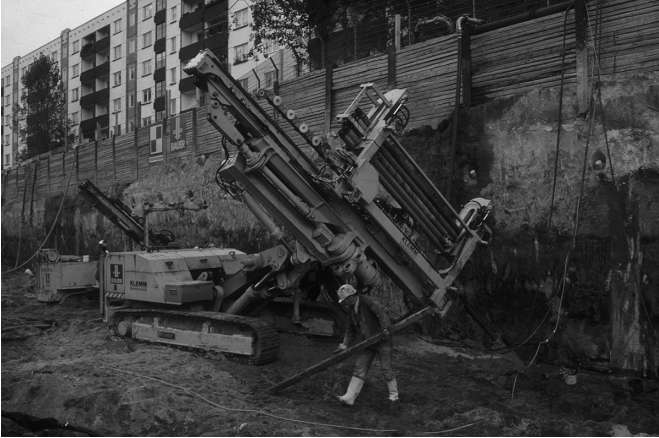
Abb. 3.2 Modernes Ankerbohrgerät mit Gestängemagazin.
