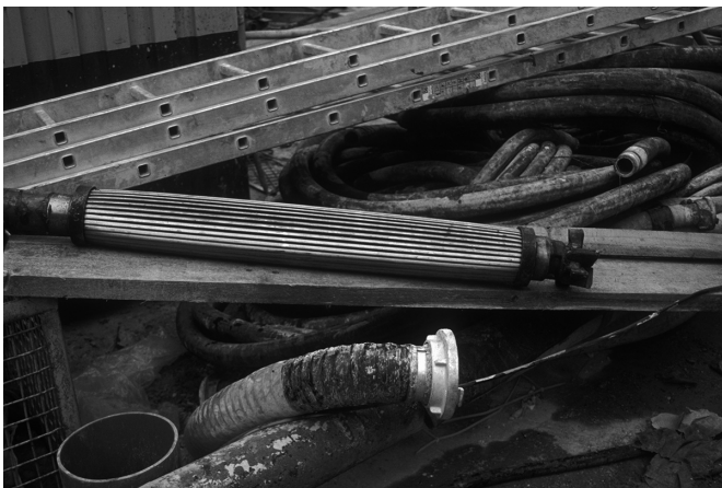
Abb. 3.14 Aufweitkörper mit Bohrspitze vor dem Einbau.
