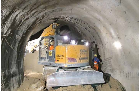
Bild 1: Tunnelbagger und Person an der Ortsbrust
