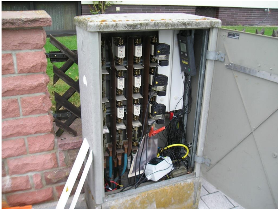
Abbildung 2-37: Installation der Messgeräte PEL103
