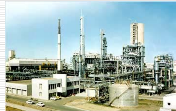
Fabrikanlage zur Ammoniaksynthese
