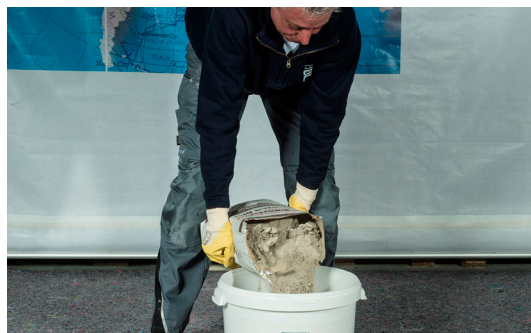
Abb. 5: Reparaturmörtel in den Mischeimer geben
