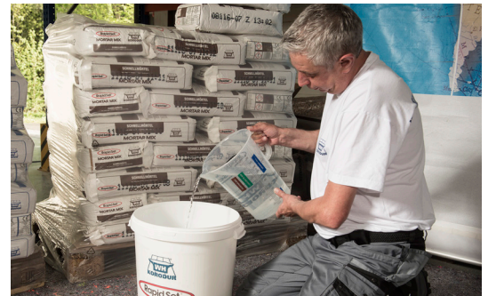
Abb. 4: Anmachwasser in den Mischbehälter vorlegen
