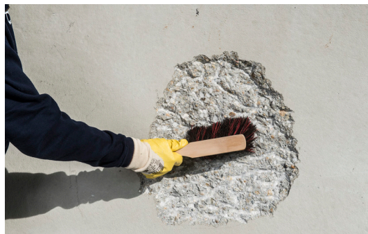
Abb. 1: Reinigen des Untergrundes
