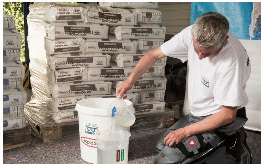
Abb. 3: Anmachwasser abmessen
