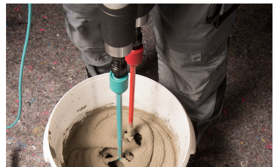
Abb. 6: Reparaturmörtel mit Doppelquirl mind. 3 Minuten mischen
