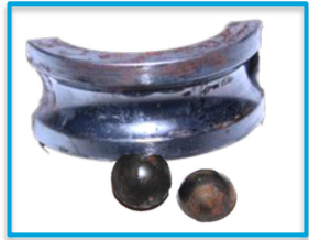
Blau- und Braunverfärbung eines heißgelaufenen Lagers
