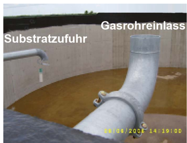
Abb. 3.36: Vorrichtungen zur störungsarmen Gasabfuhr; Gasrohreinlass mit Öffnung nach oben (links die Substratzufuhr) [DBFZ]
