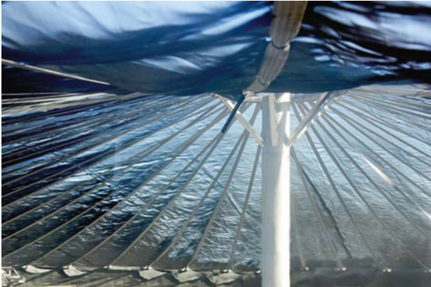
Abb. 3.39: Unterkonstruktion eines Tragluftdaches (links) [PlanET Biogastechnik GmbH]; Biogasanlage mit Tragluftdächern [MT-Energie GmbH]
