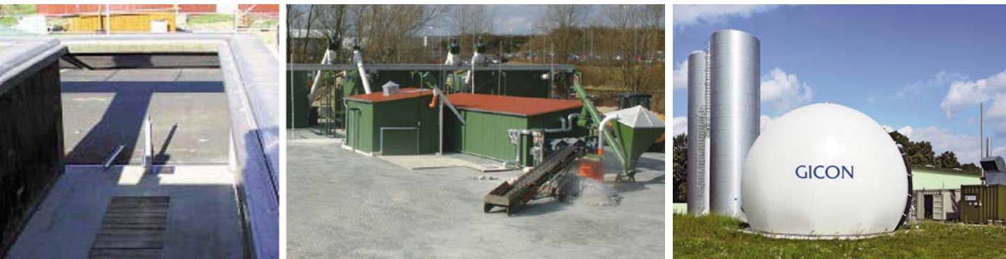
Abb. 3.29: Beispiele für Sonderbauformen in der Feststoffvergärung; Aufstauverfahren (links), durchmischte Boxenfermenter (Mitte), Methanstufe des Trocken-Nassvergärungsverfahrens und externer Gasspeicher (rechts) [ATB (links), Mineralit GmbH (Mitte), GICON Firmengruppe (rechts)]
