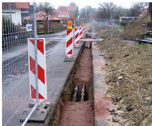
Abb. 8.2: Errichtung eines Wärmenetzes [Tannhäuser Ingenieure]
