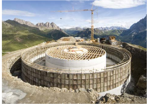
Abb. 3.30: Bau eines Betonfermenters [Wolf System GmbH]
