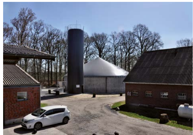
Abb. 3.50: Kleinanlage mit Kompaktfermenter (Turm) [4Biogas]
