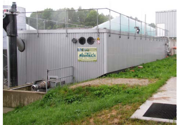
Abb. 3.26: Pfropfenstromfermenter; Praxisbeispiele, zylindrisch (links) und rechteckig (rechts), [Novatech GmbH (links), FNR/D. Riesel (rechts)]
