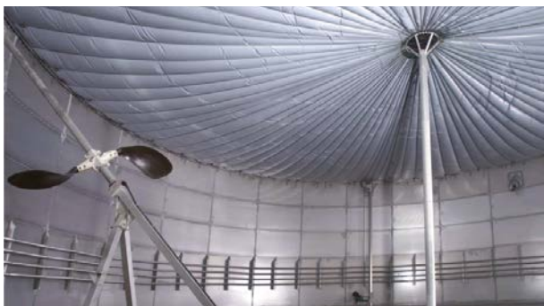
Abb. 3.33: Langachsrührwerke [WELTEC BIOPOWER (links), Armatex FTS GmbH & Co. KG (rechts)]
