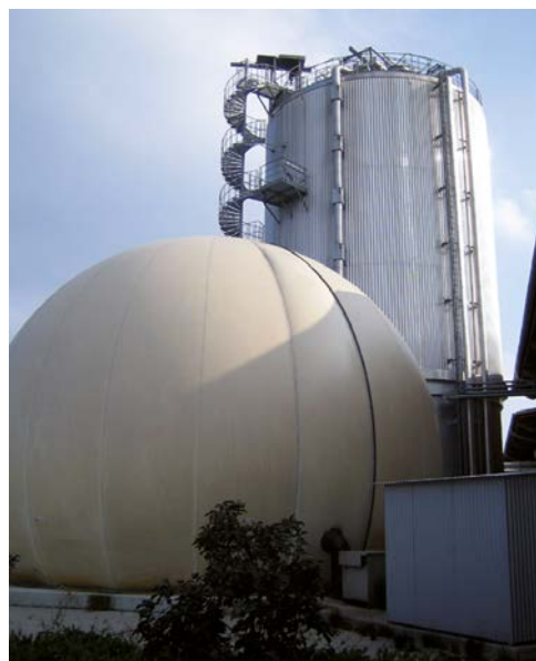
Abb. 3.41: Beispiel für freistehenden Doppelmembranspeicher [FNR/P. Schüsseler]
