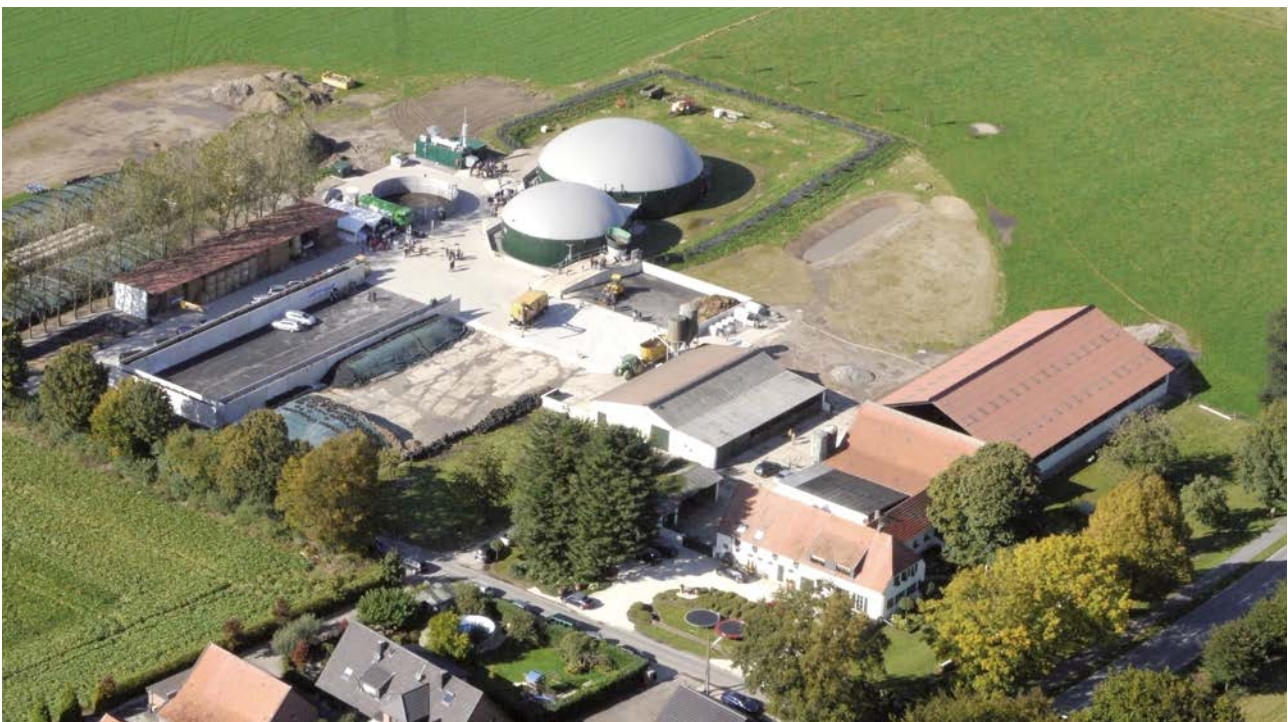
Abb. 13.1: Landwirtschaftliche Biogasanlage [PlanET Biogastechnik GmbH]
