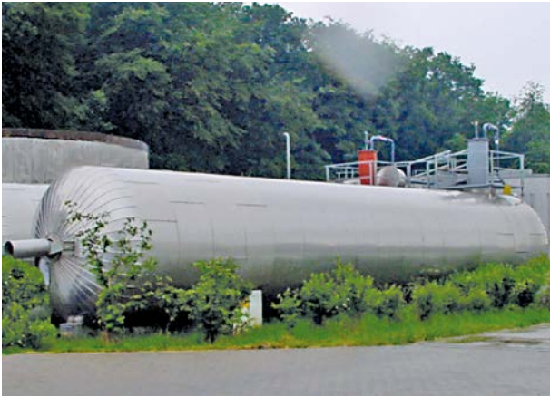
Abb. 3.26: Pfropfenstromfermenter; Praxisbeispiele, zylindrisch (links) und rechteckig (rechts), [Novatech GmbH (links), FNR/D. Riesel (rechts)]
