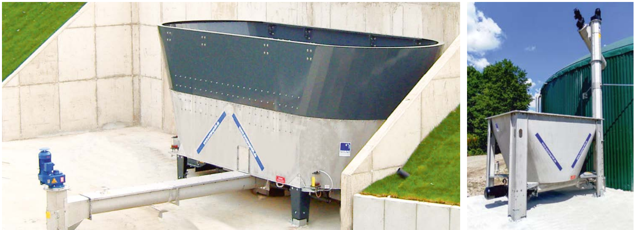
Abb. 3.20: Einbringung stapelbarer Biomasse mit Förderschnecken [Konrad Pumpe GmbH]
