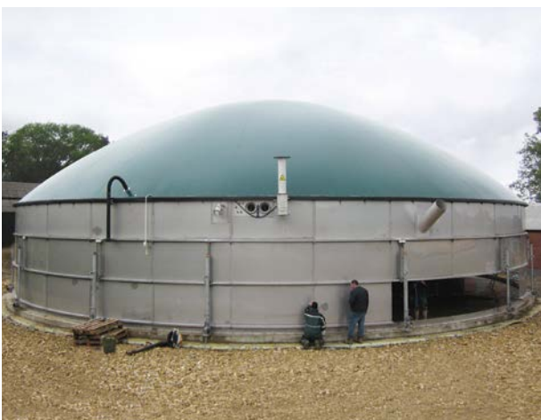
Abb. 3.31: Im Bau befindliche Edelstahlfermenter [WELTEC BIOPOWER GmbH]
