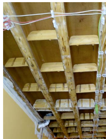
(2) Rippendecke mit verllorener Holzschalung
