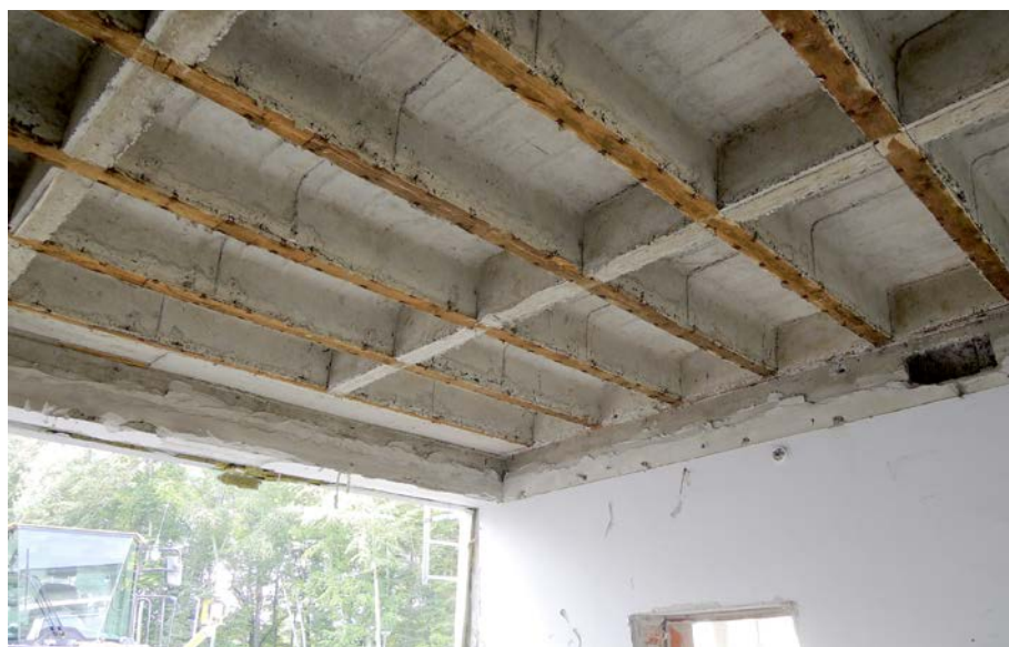
(1) Rippendecke im Bestand
