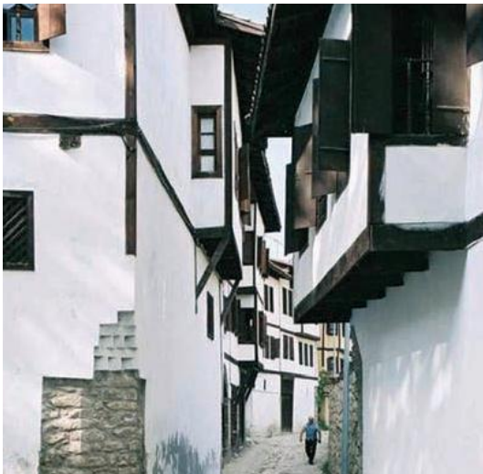
Bild 1 Traditionelle Fachwerkkonstruktion in der Türkei [6]
