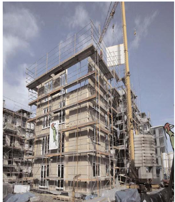
Bild 27 Mehrgeschossiger Holzbau, Bauphase [Foto: Fermacell GmbH, Duisburg]
