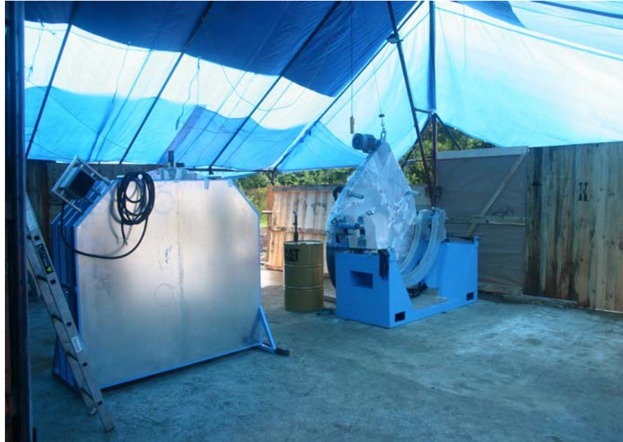
Bild 8: Überdachter und befestigter Schweißplatz
