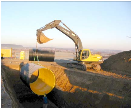
Bild 13: Einbringen der Rohre
