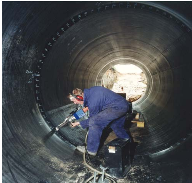
Bild 6: Handgeführter Schweißextruder
