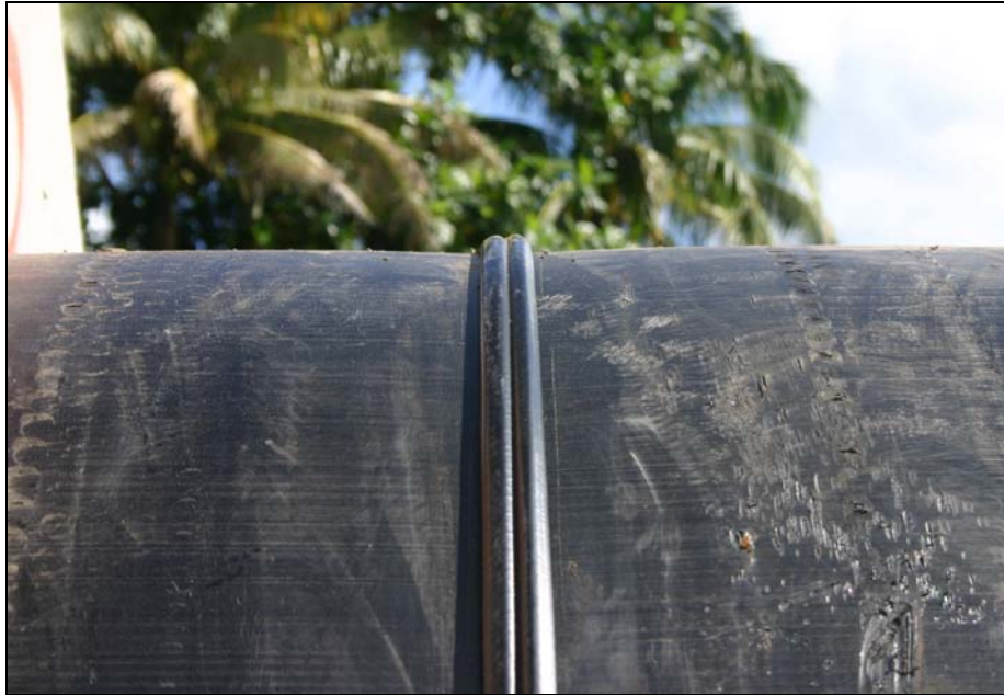
Bild 12: Fertige Schweißnaht
