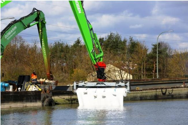
Baustellenansicht: Positionierung der Sandmatte zum Einbauen
