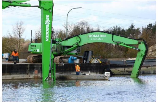
Baustellenansicht: Fixierung der Sandmatte mit einer Baggerschaufel
