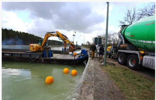
Baustellendetailansicht: Einbau Unterwasserbeton mittels Pumpe und Taucher
