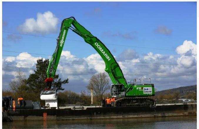
Baustellenansicht: Lagerung und Verlegung der Rollen von einer schwimmenden Arbeitsplattform
