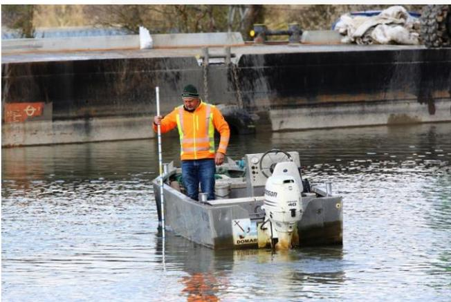
Baustellenansicht: ausloten der Wassertiefe nach Rückbau der Deckwerkssteine
