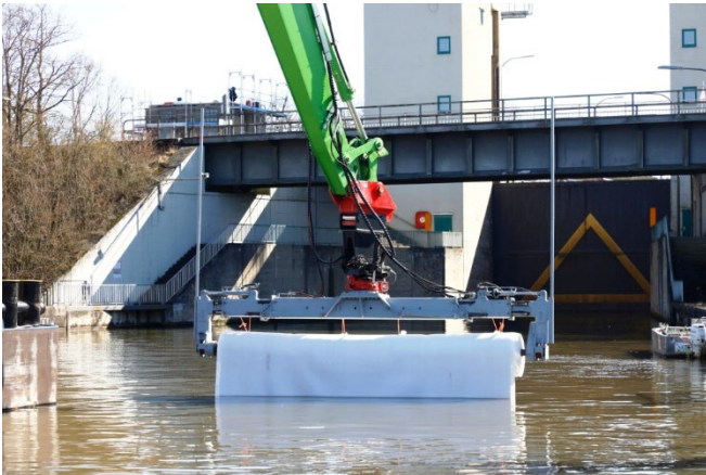
Baustellenansicht: Positionierung der Sandmatte zum Einbauen
