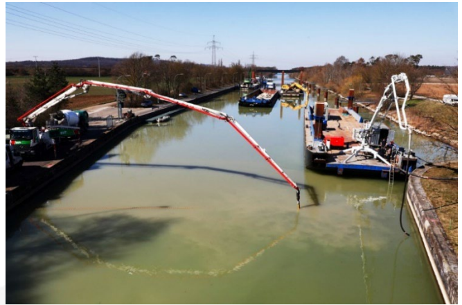
Baustellenansicht: Die Wasserbausteine werden im Nahbereich der Schleuse mit Beton verklammert – im Bild eine Transportbetonpumpe in Kanalmitte und eine am Kanalufer
