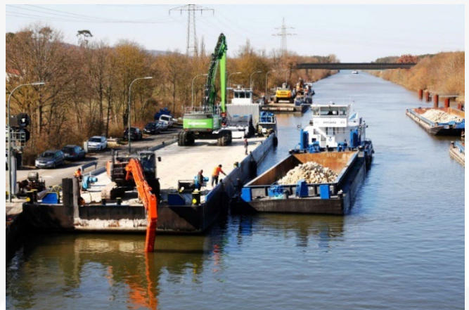
Baustellenansicht: Ankunft Schüttgutschute an Arbeitsponton
