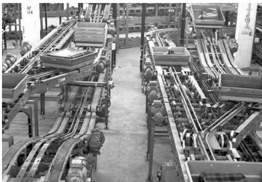
Gepäckförderanlage im Jahr 1972
