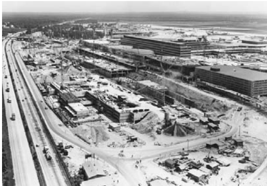
Baustelle Terminal 1, vor 1972
