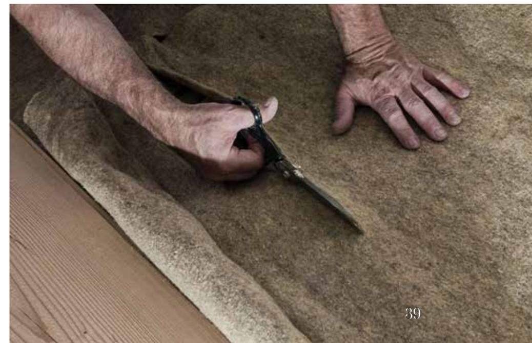
Das ist das Besondere bei diesem Fußboden: Der Unterbau wird wie ein Trockenestrich ausgeführt, dadurch entfallen lange Trockenzeiten und eventuelle Feuchtigkeit. Weil die Heizung direkt unter den Dielen liegt, wird es schneller warm und man hat weniger Energieverlust.
