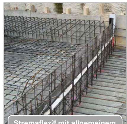
Stremaflex® mit beschichtetem Fugenblech Wand
