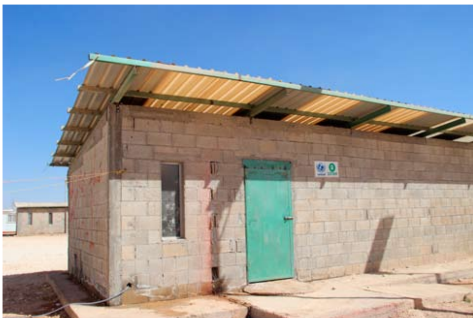
Wasser und sanitäre Anlagen im Camp Zaatari (Foto: Farah Karimi, Flüchtlinge im Libanon und Jordanien, Oktober 2013 / siehe Seite 6)
