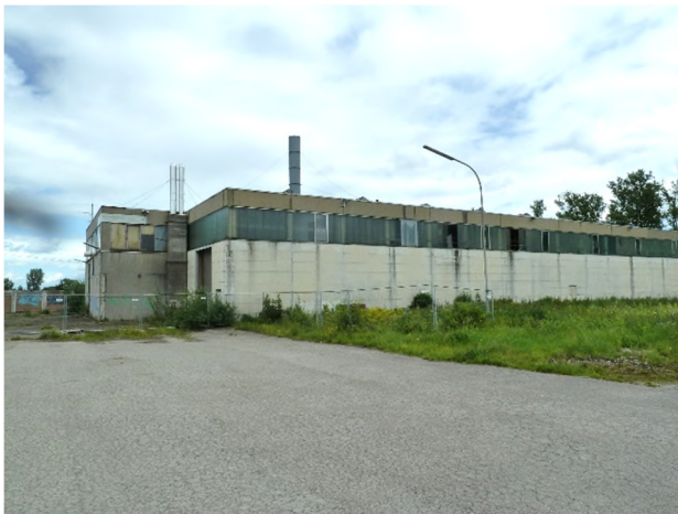
Abb.: Blick von Süden auf Gebäudekomplex und Hofflächen (Quelle LarS)
