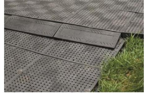
Bild 5: Dehnungsfuge überlappend
