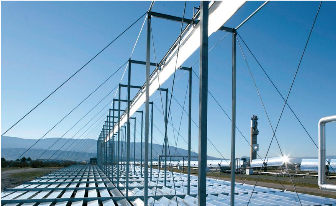
Abbildung 5: Fresnel Kollektor [24]
