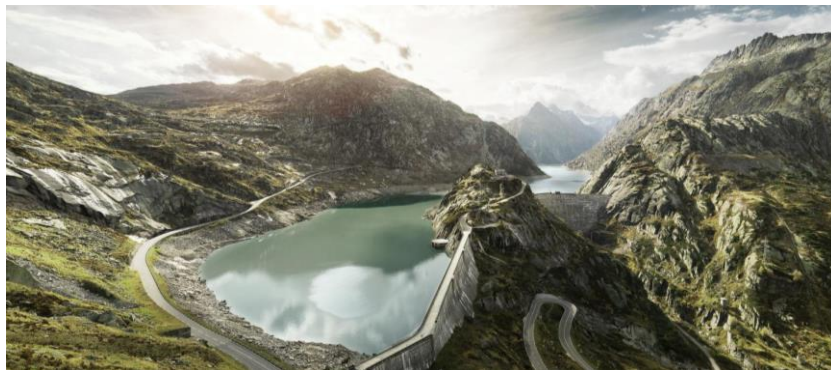
Abb. 1: Foto des Grimselsees. Der See wird durch die zwei Staumauern "Seeuferegg" und "Spitallamm" mit einer maximalen Höhe von 114 m, aufgestaut.
