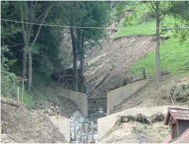
Abb. 1 Sägezahnartige Abrisskanten und flachgründige Rutschungen aufgrund Ufererosion (links) und Vermurungsbereich eines Hanggerinnes (rechts). An der dem Bachlauf zugewandten Hauswand sind Anschlagmarken des Murganges zu erkennen. Quelle: A. Kociu, Fotoarchiv der GBA.
