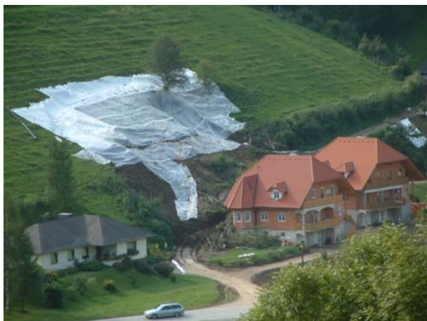
Abb. 2 Böschungsbrüche in Folge Hanganschnitt und resultierender bergwärtiger Hangübersteilung (links) sowie in Folge Hanganschnitt/Anschüttung und resultierender talwärtiger Hangübersteilung (rechts). Quelle: N. Tilch, Fotoarchiv der GBA.
