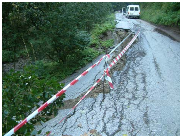
Abb. 2 Böschungsbrüche in Folge Hanganschnitt und resultierender bergwärtiger Hangübersteilung (links) sowie in Folge Hanganschnitt/Anschüttung und resultierender talwärtiger Hangübersteilung (rechts). Quelle: N. Tilch, Fotoarchiv der GBA.
