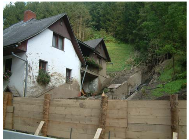
Abb. 1 Sägezahnartige Abrisskanten und flachgründige Rutschungen aufgrund Ufererosion (links) und Vermurungsbereich eines Hanggerinnes (rechts). An der dem Bachlauf zugewandten Hauswand sind Anschlagmarken des Murganges zu erkennen. Quelle: A. Kociu, Fotoarchiv der GBA.
