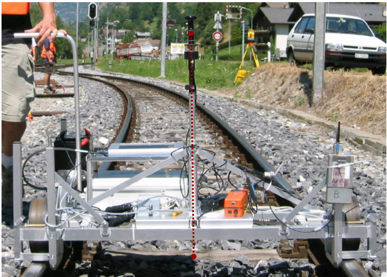
Abbildung 4: Trimble 360° Prisma mit Höhe 79.0 cm über Gleis
