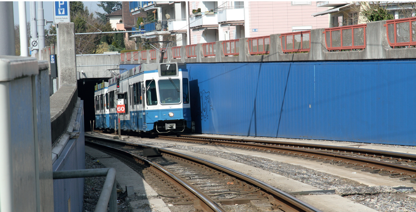
Abb. 1: Der Straßenbahntunnel verläuft direkt unter den angrenzenden Wohngebäuden.
