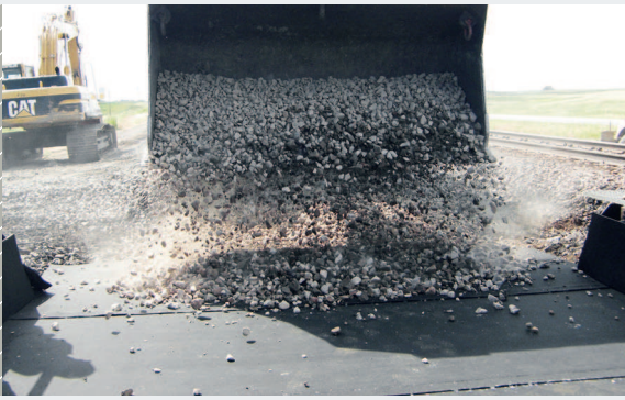
Einbau von Unterschottermatten auf einer Brücke in den USA
