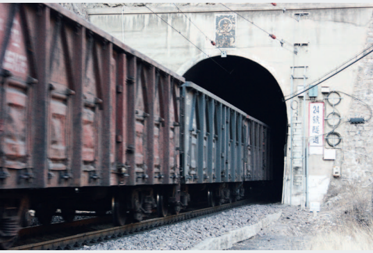
Übergang von freier Strecke in einen Tunnel
