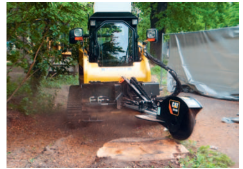
Mit Anbauausrüstung können kompakte Lader wie dieser Cat-Deltalader die unterschiedlichsten Arbeiten übernehmen.
