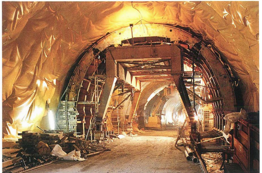
Die mit PVC-Folie verkleidete Tunnelröhre, im Vordergrund die Schalung für das Betonieren des Innenrings.
