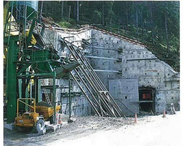
Der Voreinschnitt mit der Ankerwand und den beiden Sohlstollen.
