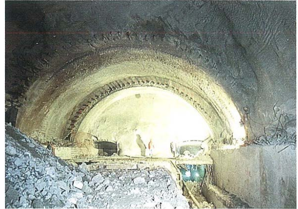
Der Übergang vom Fels zur Lockergesteinsstrecke mit dem Mikropfahlschirm und den beiden Sohlstollen.
