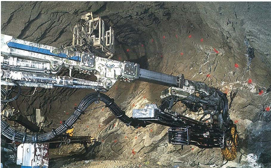
Vortrieb im Bergeller Gneis: Das Bohren der Sprenglöcher
