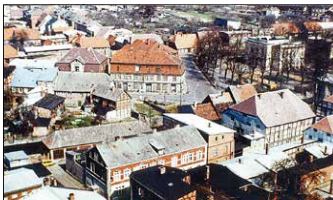
Ansicht in Richtung Steindamm / Kießerdamm 1982
