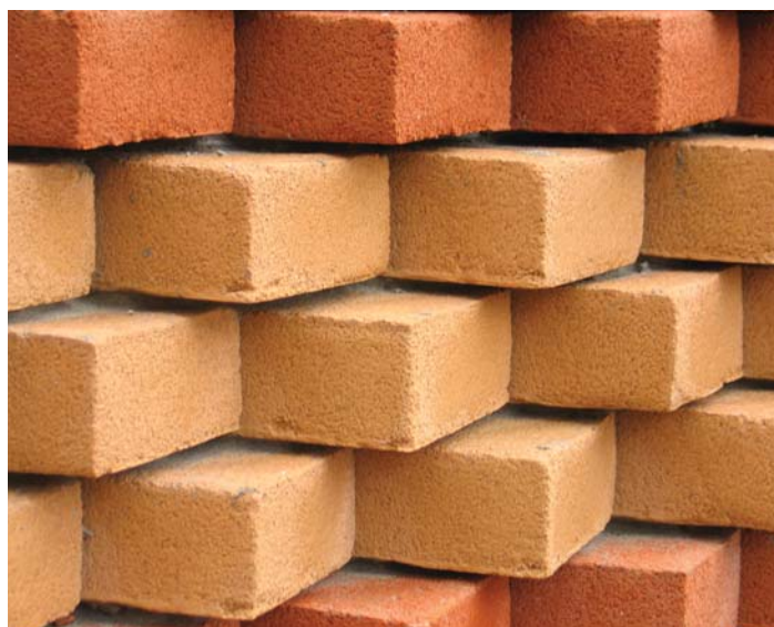
Ein mehrfarbiges Raster aus Ziegelsteinen verlegt mit MALTA A VISTA GRIGIA (Cantù-CO)
