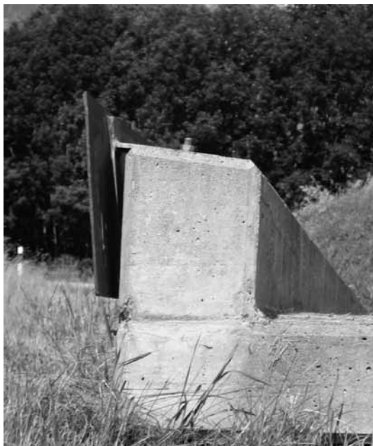
Prellplatte an der Dachstirne montiert
