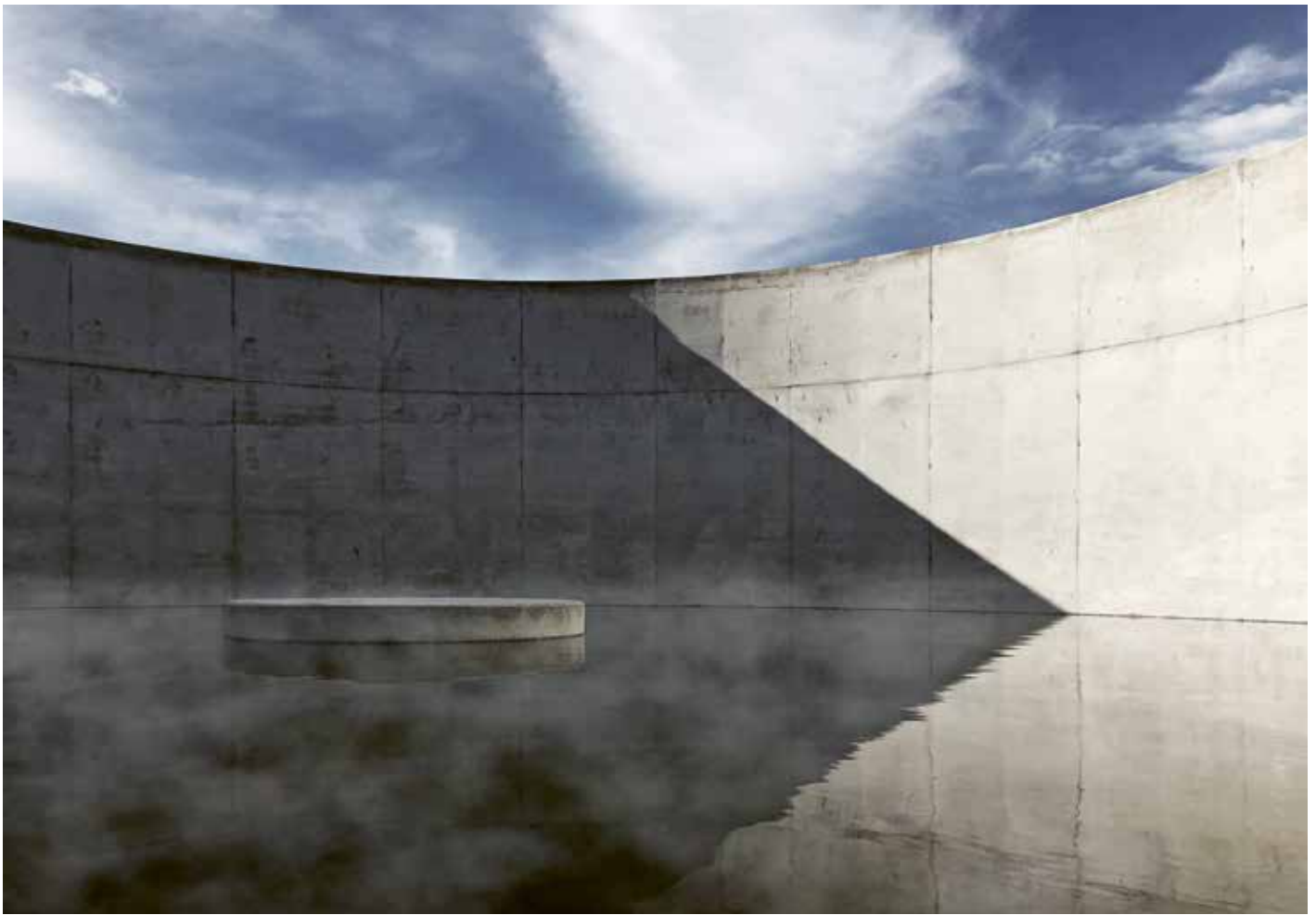
Infrastrukturgebäude aus Recyclingbeton zur Speicherung von Biomasse aus Abfallstoffen: Christoph Hesse Architects, Grüne Energieanlage, Referinghausen 2016, Foto: Christoph Hesse
