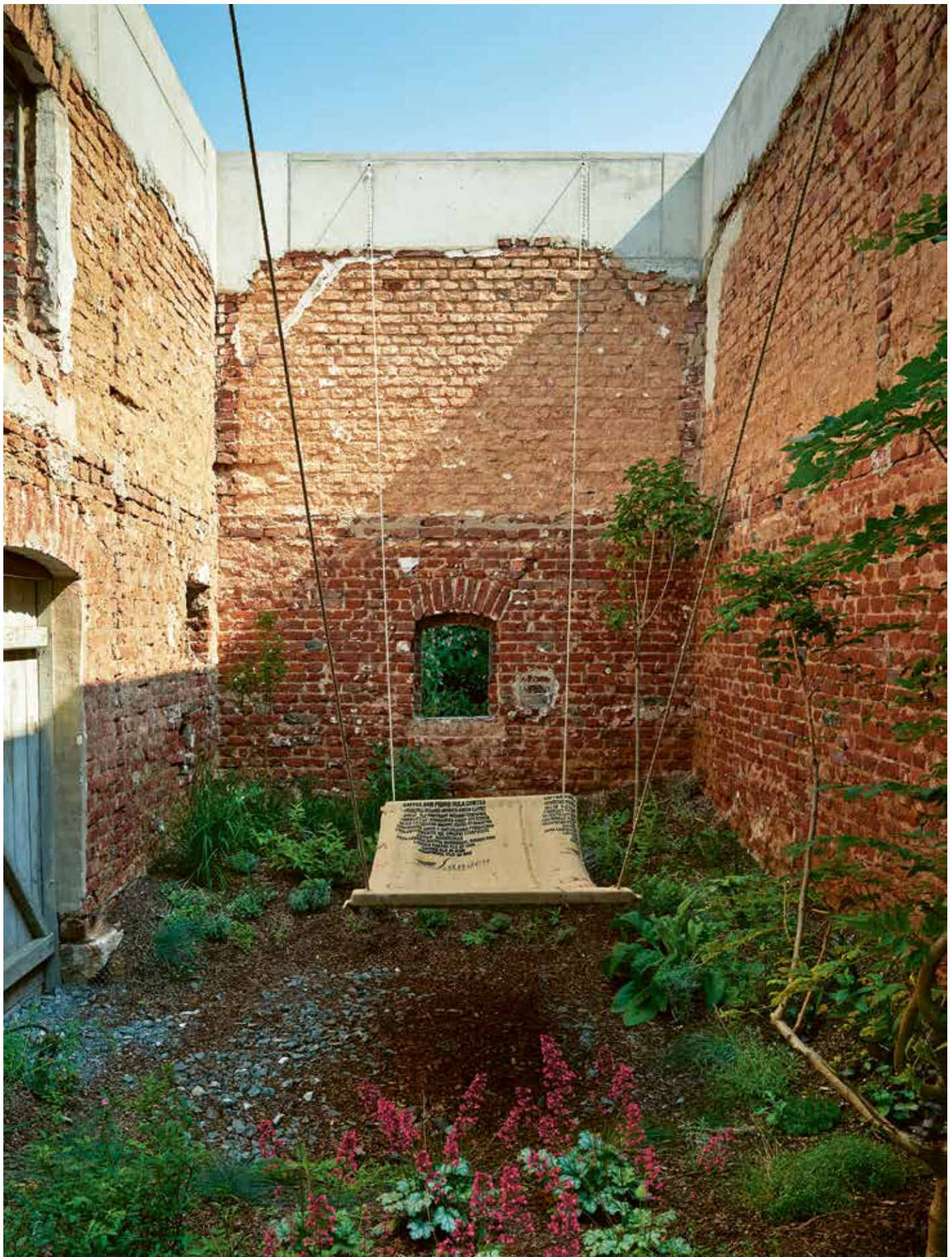
Umbau eines ehemaligen Ziegenstalls zum Treffpunkt unter freiem Himmel; die vier Seile der Hängematte symbolisieren die Windräder, Wasserkraft-, Biogas- und Photovoltaikanlagen der Stadt; Christoph Hesse Architects, Raum der Stille, Korbach 2019, Foto: Deimel + Wittmar
