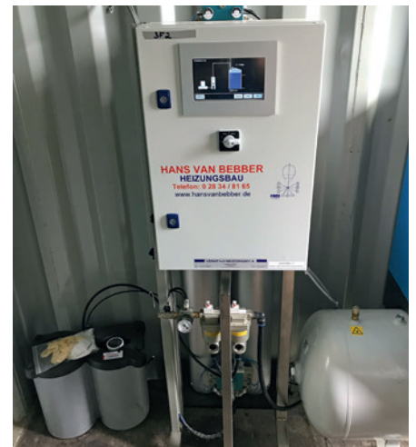
In einem kleinen Technikcontainer für den neuen Pufferspeicher ist die Regelung für die Stickstoffzugabe in den Speicherbehälter untergebracht. Der Stickstoff verhindert Korrosion. Fotos: Meier, Werkfotos (1)
