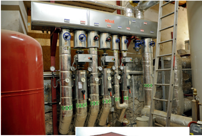
Der erste Pufferspeicher für Wärme wurde in einem ehemaligen Kuhstall (rechts) untergebracht. Von ihm führen mehrere Stränge zu den Verbrauchern (oben).
