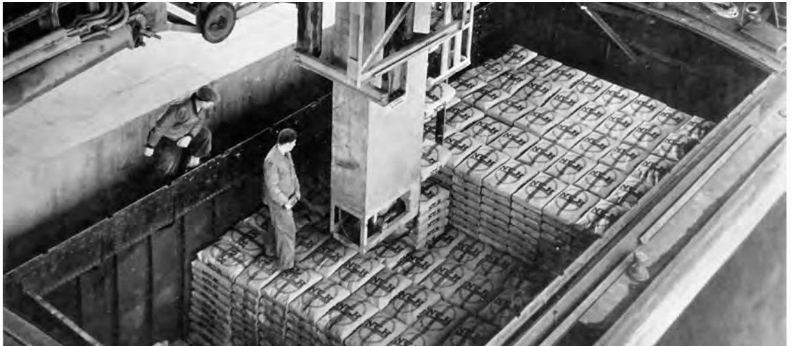
Verladung im neuen Hafen durch die vollautomatische Stapelanlage, hier für den Export in die Niederlande, 1956. In den 1970er Jahren wurden bereits 70 % des Zements lose per Silo-LKW transportiert. Sackware wurde zu 17 % per Schiff, zu 11 % per LKW und nur noch zu 2 % per Bahn transportiert.
