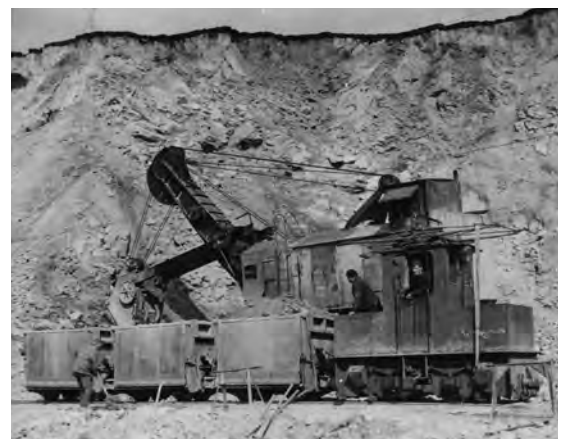
Elektro-Bagger bei der Verladung in die Lorenbahn im Steinbruch Süd der Teutonia, 1950.
