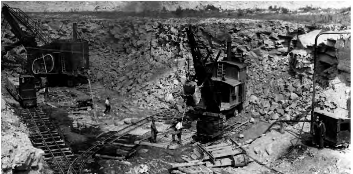
Aushebung der Grube für den Titanbrecher, der aber kriegsbedingt erst 1959 errichtet werden konnte, ca. 1938.
