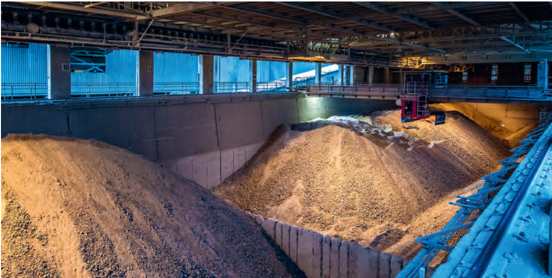
Lagerhalle für Kalkmergel, 2014.
