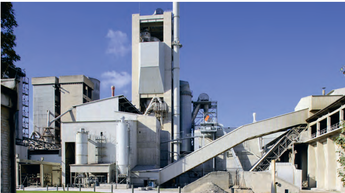
Ofenlinie 7, Kurzdrehofen mit Kalzinator mit 2.500 t Tagesleistung, 2004.
