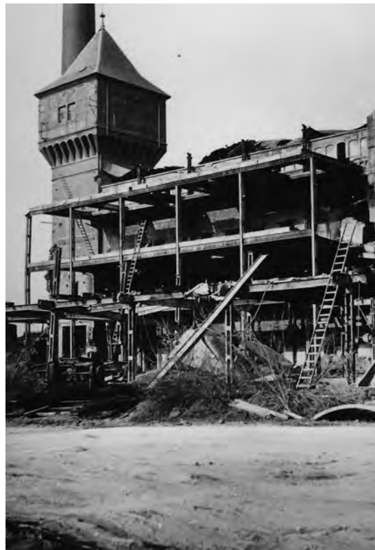
Bombenschäden am ehemaligen Pressenhaus, ca. 1945.
