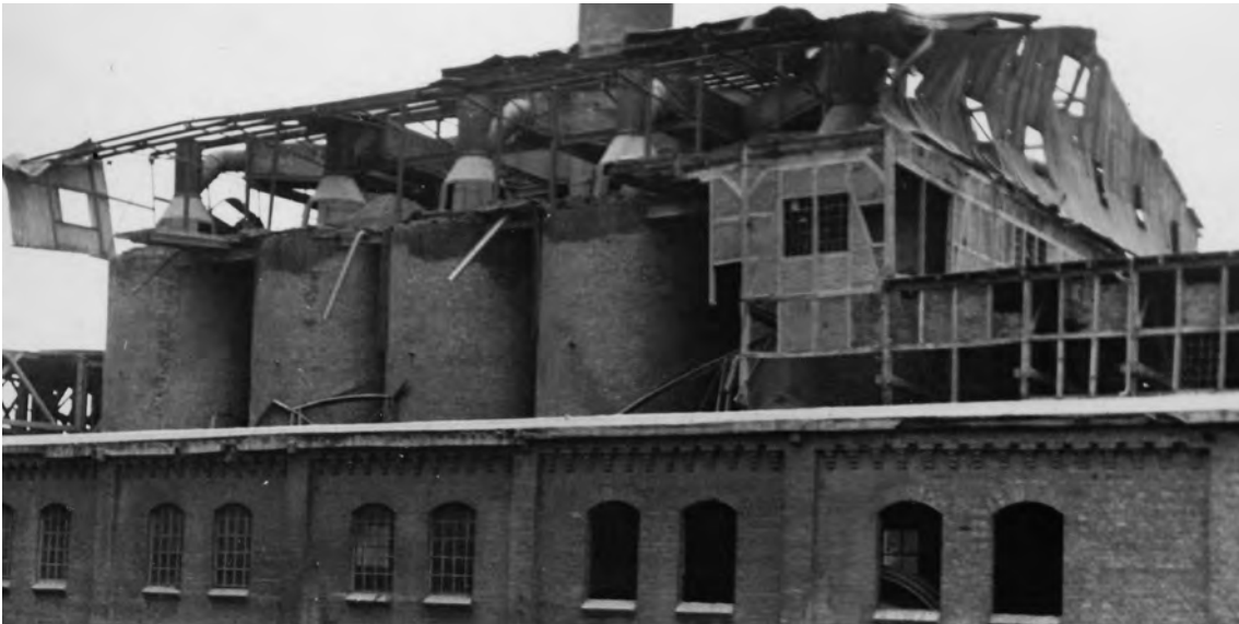
Beschädigte Schachtöfen vor der zerstörten Ofenhalle, ca. 1945.
