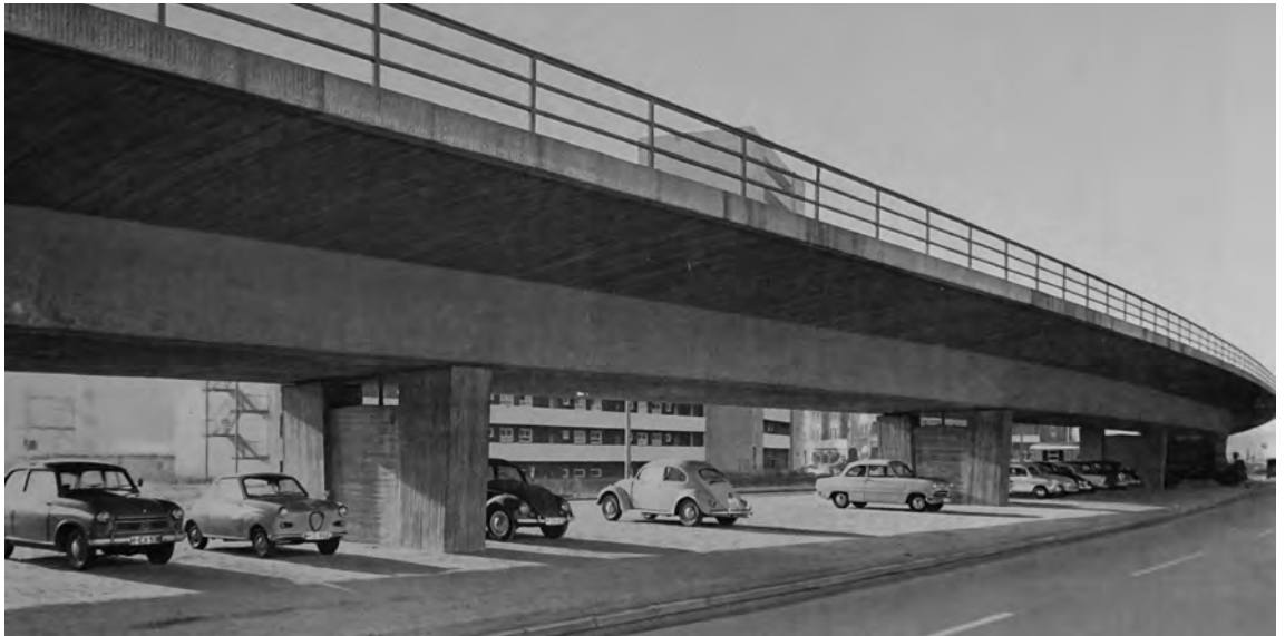
Verwendung von Teutonia-Zement im Hochstraßenbau, 1965.
