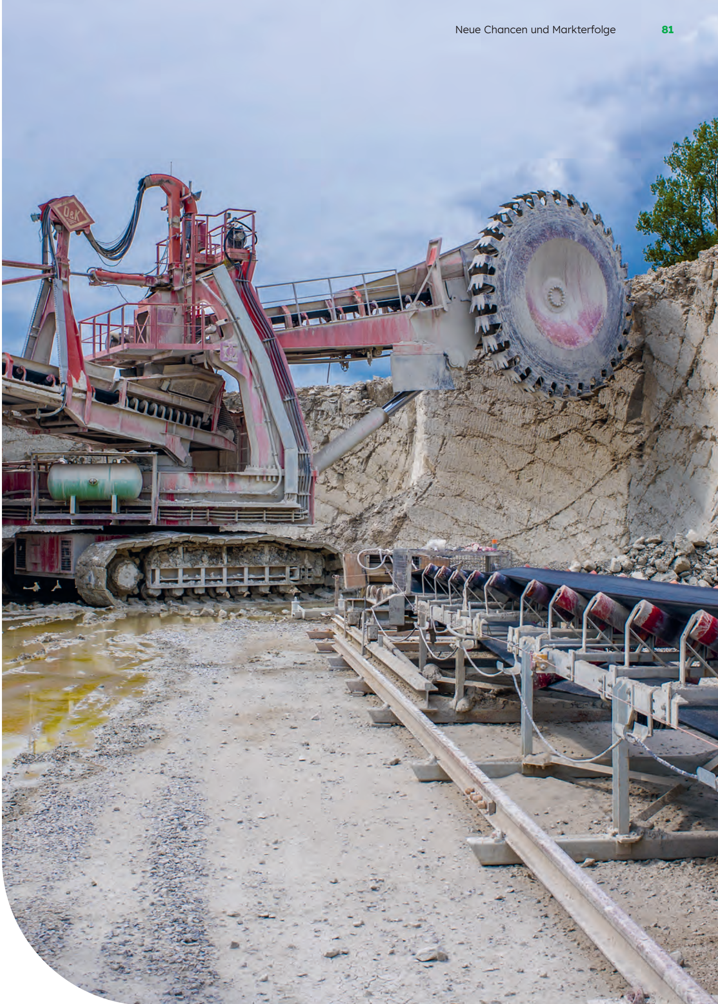
O&K Schaufelradbagger zur kontinuierlichen Rohmaterialförderung, 2017.
