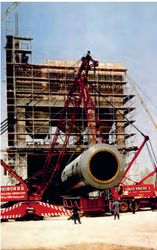
Einbau der Zementmühle 10, 1971.
