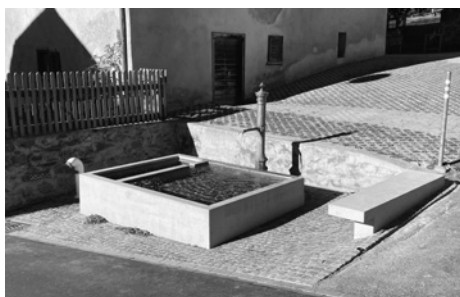
Der alte Brunnen von Sagogn (oben) musste 2019 einem kleinen Ersatztrog weichen (Mitte). Nach nur einem Jahr wurde dieser wieder entsorgt und zur Zufriedenheit aller durch eine neue Betonkonstruktion von Bildhauer Dominik Zehnder ersetzt (unten).
