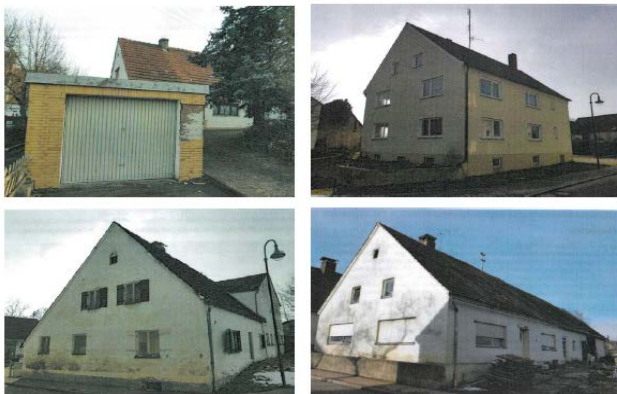
Abbruch von 4 Gebäuden → Förderung 182T€ (75% von 243T€)
