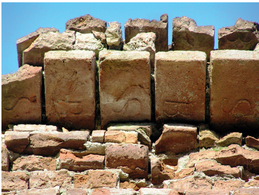
Abb. 6. Gesimsziegel (Länge 44 cm) des 18. Jahrhunderts mit dem erhabenen Zeichen BS in Horné Semerovce, Slowakei; Foto Paul Mitchell.
