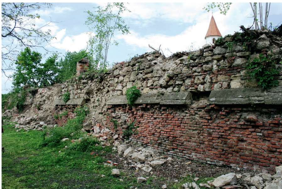
Abb. 3. Die Ruinen der sog. Pfaffenbastei mit Fortifikationsziegeln des 16. Jahrhunderts (Länge 31 cm) in Bad Radkersburg, Steiermark; Foto Paul Mitchell.
