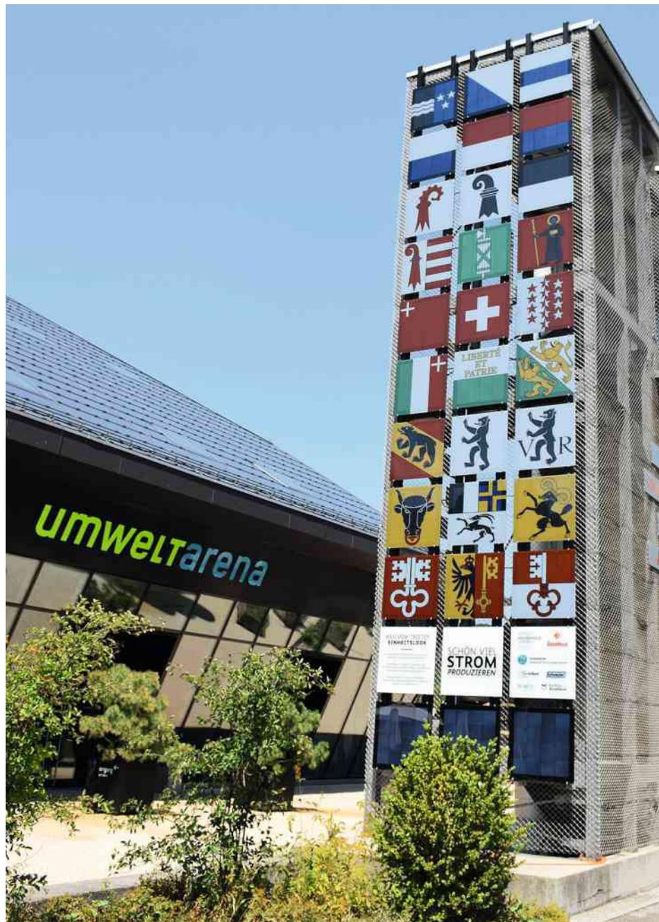
Photovoltaikanlage «Swissness» vor dem Eingang zur Umwelt Arena: PV-Module können heute mit beliebigen Farben und Mustern bedruckt werden. 80% der Leistung von herkömmlichen Panels können trotzdem erreicht werden. (Umwelt Arena, HSLU, [www.hslu.ch/umweltarena](http://www.hslu.ch/umweltarena) › Live Monitoring)
