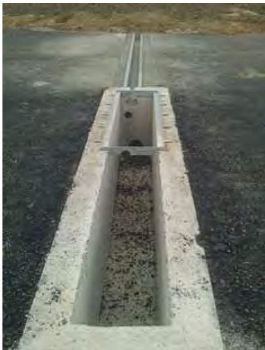
Betonkassette für ein Wasserhindernis
