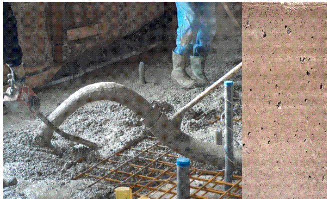
Abb. 10: Beton im Hochbau
