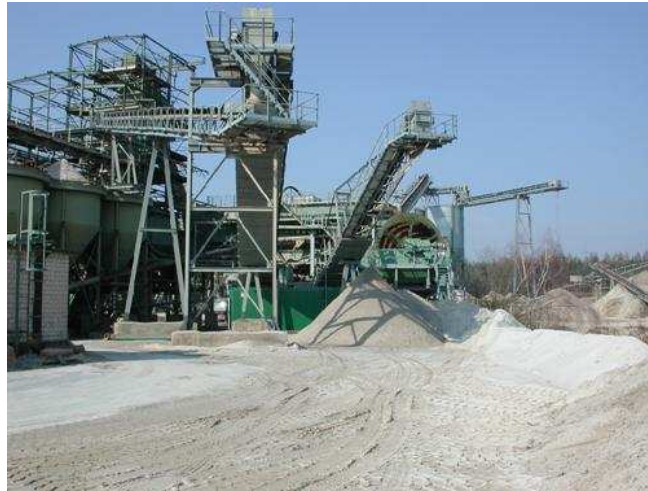
Abb. 26: Aufbereitungsanlage für Main-Kies bei Rodgau-Dudenhofen
