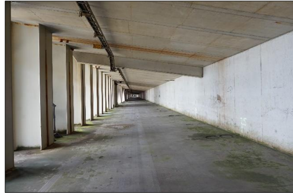
Abbildung 52: Links: Hochwasserschutzwand am Burchardkai in Hamburg (Alexander Hoernigk (2011), Wikipedia); rechts: Wellenkammer der Stromkaje am Containerterminal in Bremerhaven.
