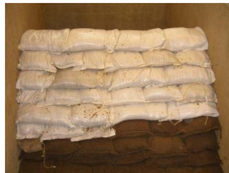
Abb. 59: Fertiger Notdamm
