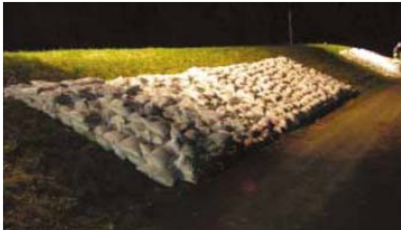
Abb. 15: Stützung mit Sandsäcken mit Sickerrost 30
