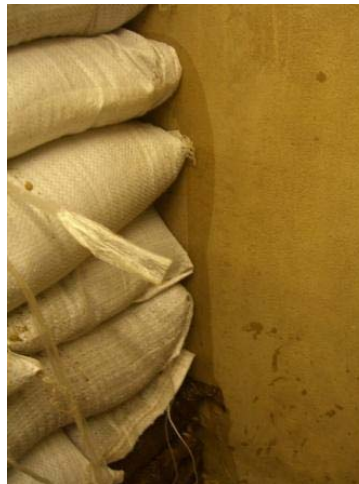
Abb. 63: Undichte Fuge
