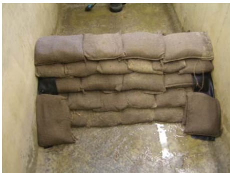
Abb. 67: Damm mit seitlicher Dichtung
