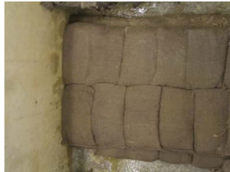
Abb. 66: 2.Lage Damm nach Regelaufbau
