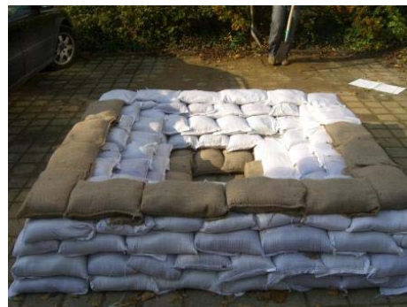
Abb. 50: Fertiges Notdammbecken
