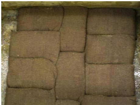
Abb. 65: 1.Lage Damm nach Regelaufbau
