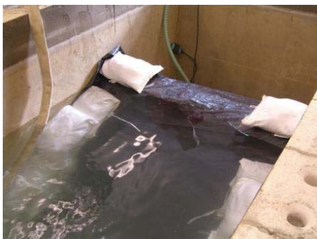
Abb. 60: Notdamm bei Volleinstau
