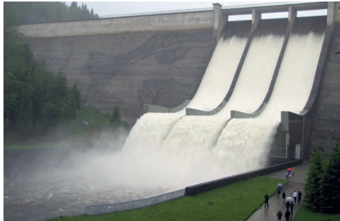
Die Talsperre Eibenstock bei laufender Hochwasserentlastung – Vorhersagewerkzeuge unterstützen den Betreiber dabei, die Steuervorgaben im Hochwasserfall optimal einzuhalten (Foto: LTV Sachsen).
