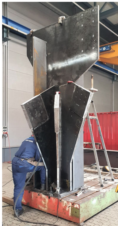
Bild 8 Unterer Eckknoten in Werksfertigung Lower corner node in steel shop fabrication
