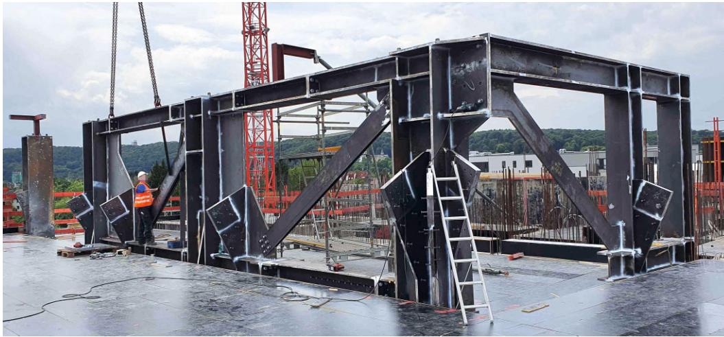
Bild 9 Stahlbauteile der Wandkonstruktion im 3. OG Steel components of the wall construction on the 3 rd floor
