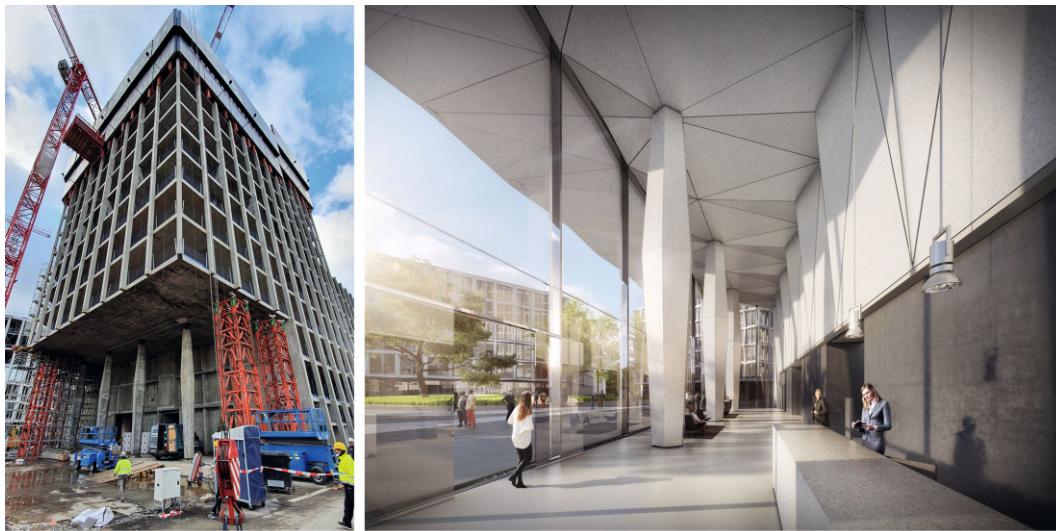
Bild 6 a) Baustand beim Rückbau der Unterstüctungsstruktur, b) Visualisierung der Foyerstücten im Endzustand a) Construction status when removing the supporting structure, b) visualisation of the foyer columns in their final state
