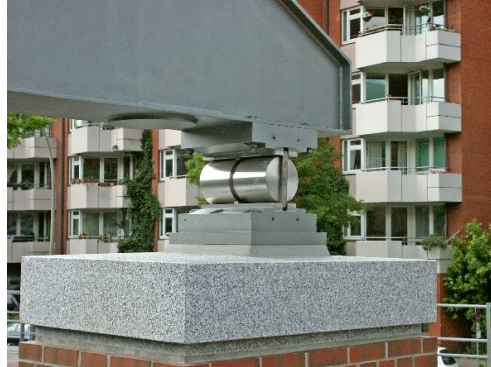
Brückenlager (Loslager in Längsrichtung und Festlager in Querrichtung)
