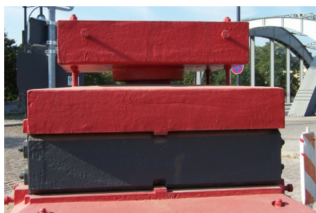
bewegliches Brückenlager (Vorder- und Seitenansicht), Baujahr 1918, Gewicht 6,8 Tonnen, Verstellweg \pm 6 cm (Magdeburg, Hammersteinweg)
