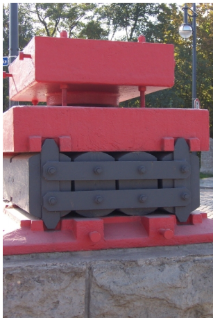
Brückenlager (Loslager in Längsrichtung und Festlager in Querrichtung)
