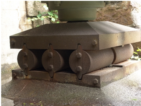
Brückenlager (Loslager in Längsrichtung und Festlager in Querrichtung)
