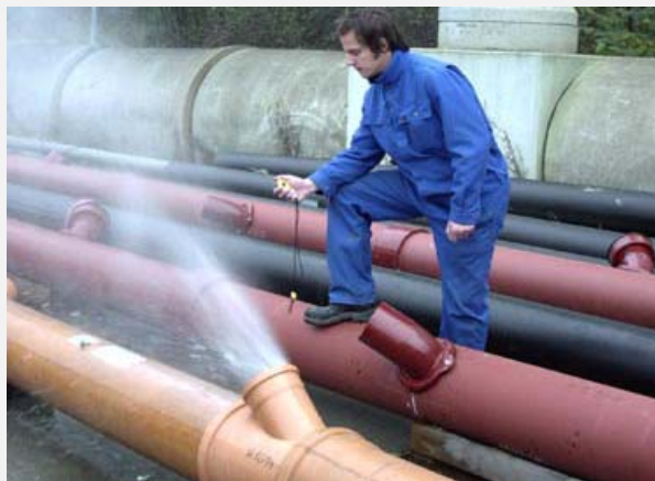
Bild 122: Stat. Belastung durch 3-minütigen Stillstand der Düse an einer Stelle
