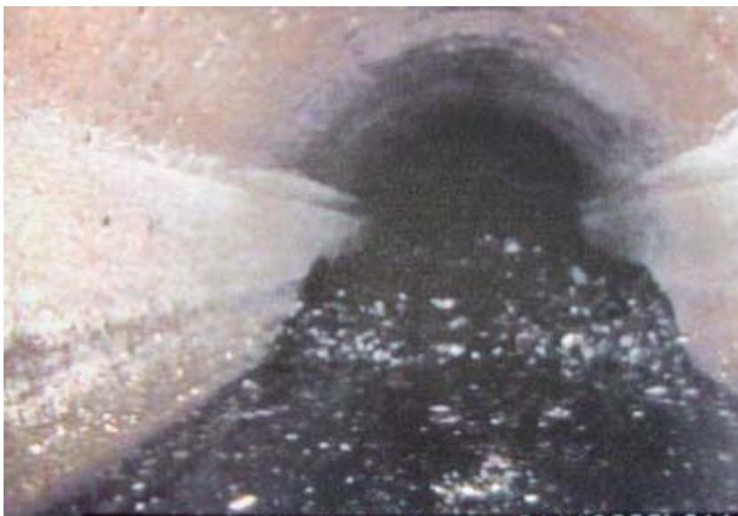
Bild 49: Praxisbeispiel: Durch Hochdruckreinigung aufgebaute Verstopfung, bei der sich Schlauch und Düse in den Ablagerungen festsetzten.
