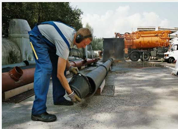
Bild 124: Einfüllen des Prüfgeschiebes
