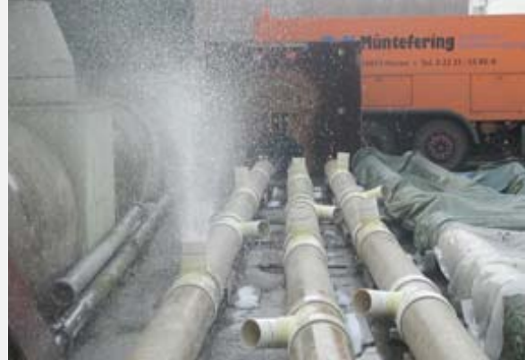
Bild 121: 90° Abzweig während der Prüfung
