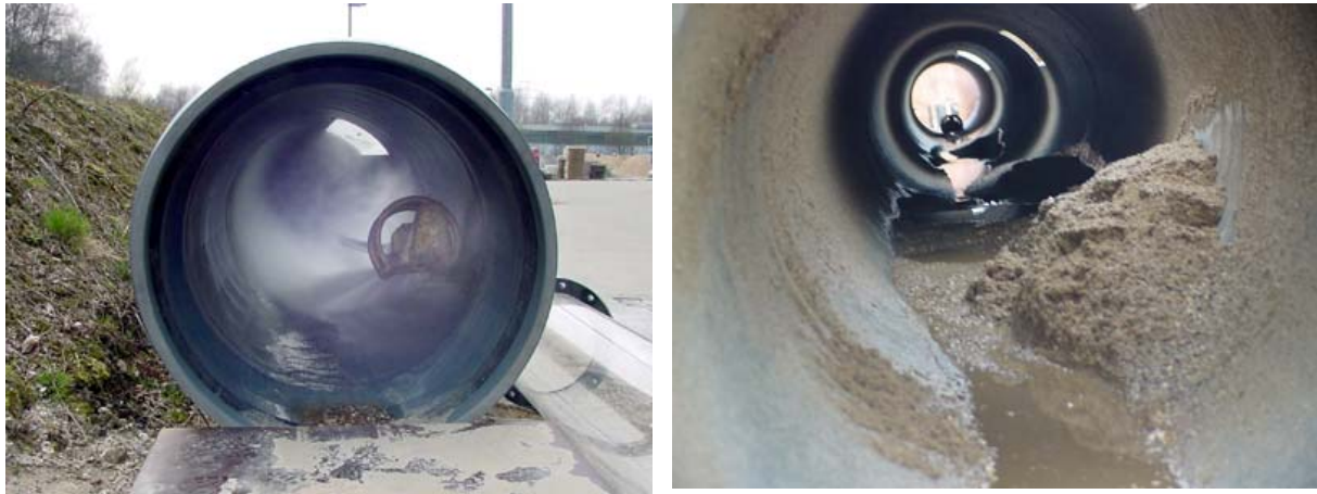
Bild 68: IKT-Prüfstrecke DN 800 (PVC), Räumversuch, Bildbeispiel:
