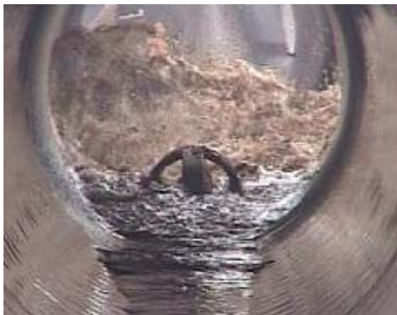
Bild 72: Düse an der Leistungsgrenze
