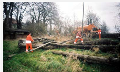
c) Zugänglichkeit: Schacht im Gelände
