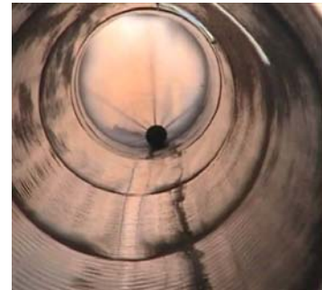
Bild 63: Freigespülte Strecke
