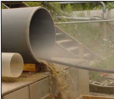
Bild 61: Einspülen der Düse
