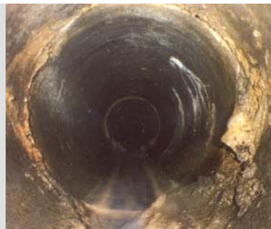
Inkrustation nach erster Reinigung, stellenweise
