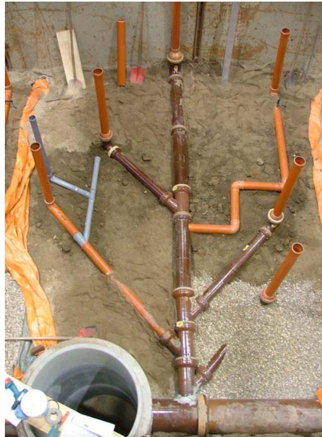
Abb. 9: Netz 3: Grundstücksentwässerungsnetz und Schacht als Netzzugang vor Bodeneinbau
