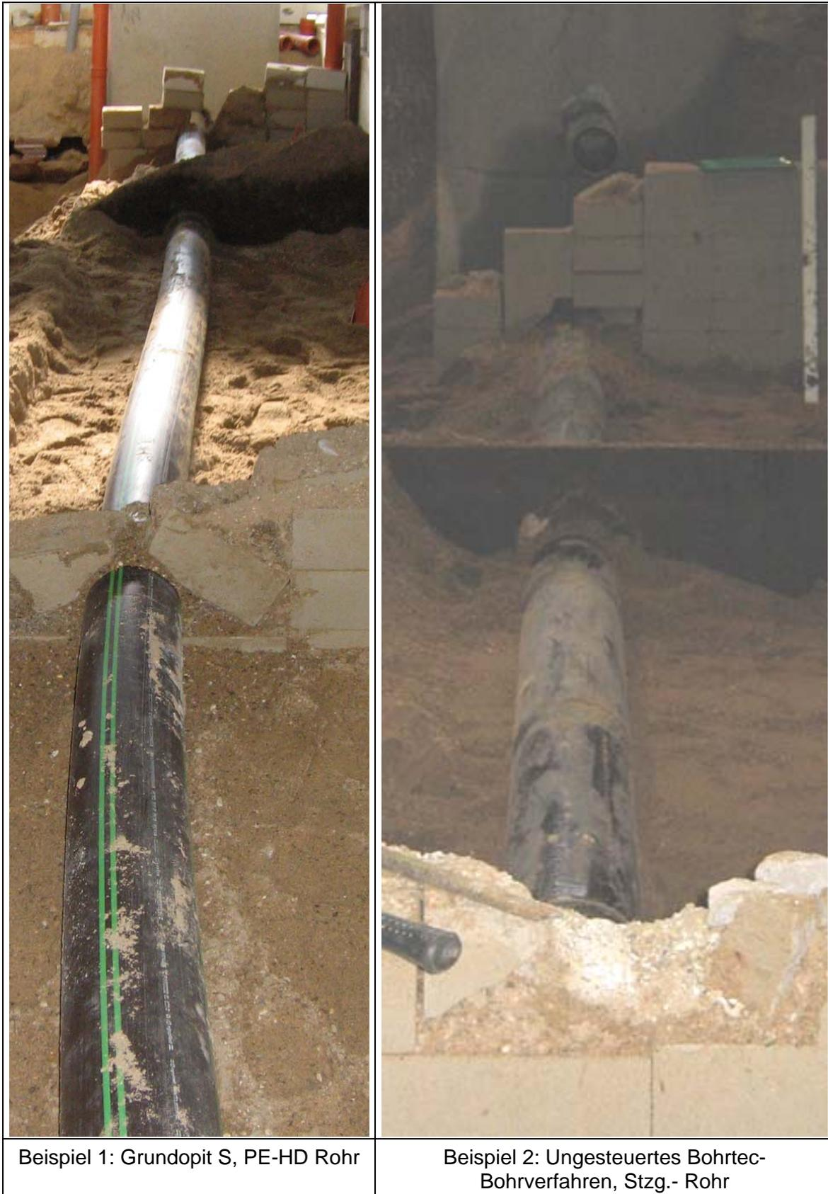
Abb. 22: Verlauf der Bohrtrassen, Beispiele
