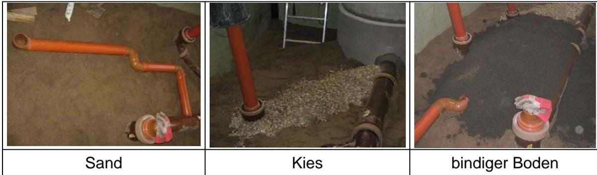
Abb. 27: Netzbereiche mit unterschiedlichen Böden
