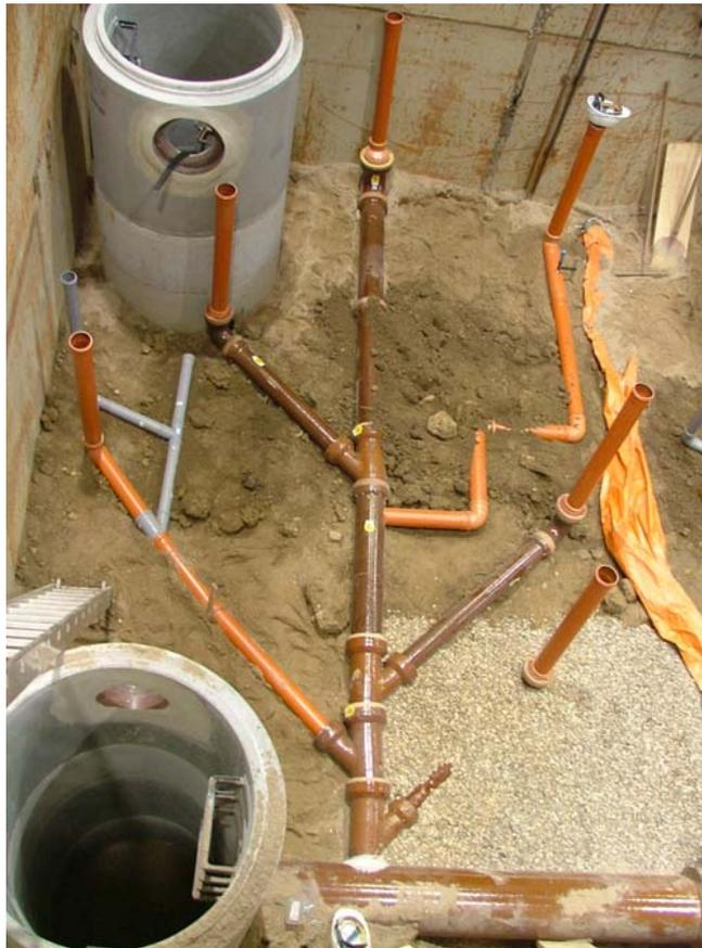
Abb. 8: Netz 2: Grundstücksentwässerungsnetz und Schacht als Netzzugang vor Bodeneinbau
