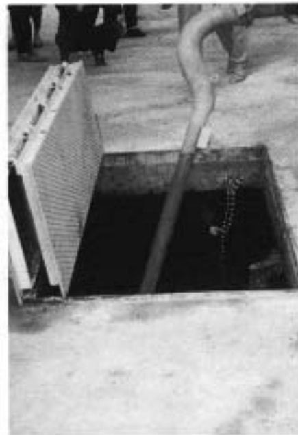
Abb. 1. Die gemeinsame Vergärung fester und flüssiger Co-Substrate mit Gülle verbessert die Wirtschaftlichkeit landwirtschaftlicher Biogasanlagen. Bild links: Co-Vergärung von Getreideabgang und Mist. Bild rechts: Co-Vergärung von Gemüseabfällen (Zugabe flüssiger Gemüseabfälle in die Vorgrube).
