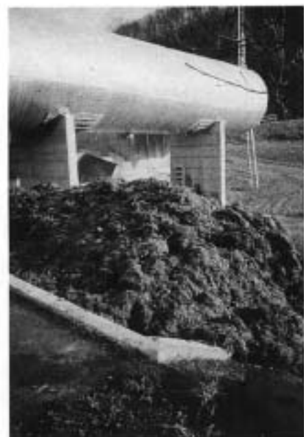
Abb. 1. Die gemeinsame Vergärung fester und flüssiger Co-Substrate mit Gülle verbessert die Wirtschaftlichkeit landwirtschaftlicher Biogasanlagen. Bild links: Co-Vergärung von Getreideabgang und Mist. Bild rechts: Co-Vergärung von Gemüseabfällen (Zugabe flüssiger Gemüseabfälle in die Vorgrube).
