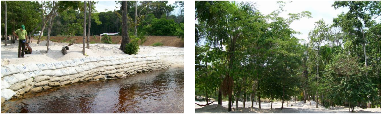
Figura IVB 17. Floresta de baixo no Município de Novo Airão, apresentando alteração antrópica: barragem e deposição de areia para uso de banistas.
