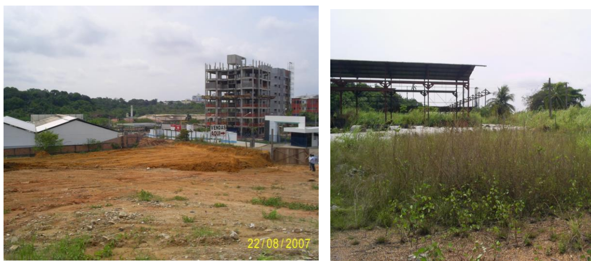
Figura IVB 04 – Futura área residencial com solo sem cobertura (esquerda) e fábrica de artefatos com espécies ruderais sobre solo piçarrento (direita).
